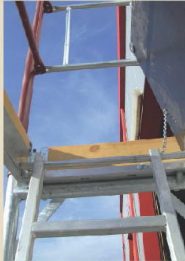
Siebdruck-Arbeitsbühnen mit einer Stärke von 12mm, die sich mit Hilfe der 65cm dicken Verbindungsstreben aus Aluminiumprofil (T) in Rahmen befinden, verfügen über eine Tragfähigkeit von 200kg.
