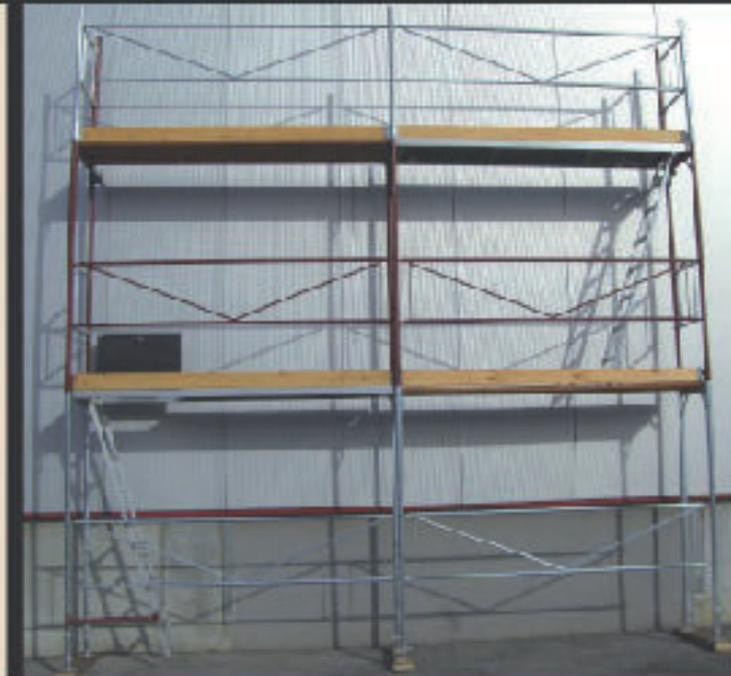
TRAGFÄHIGKEIT DER ARBEITSBÜHNEN: HOLZ BIS ZU 200KG/M<sup>2</sup> UND ALU BIS ZU 200KG/M<sup>2</sup> BZW. 300KG/M<sup>2</sup>
