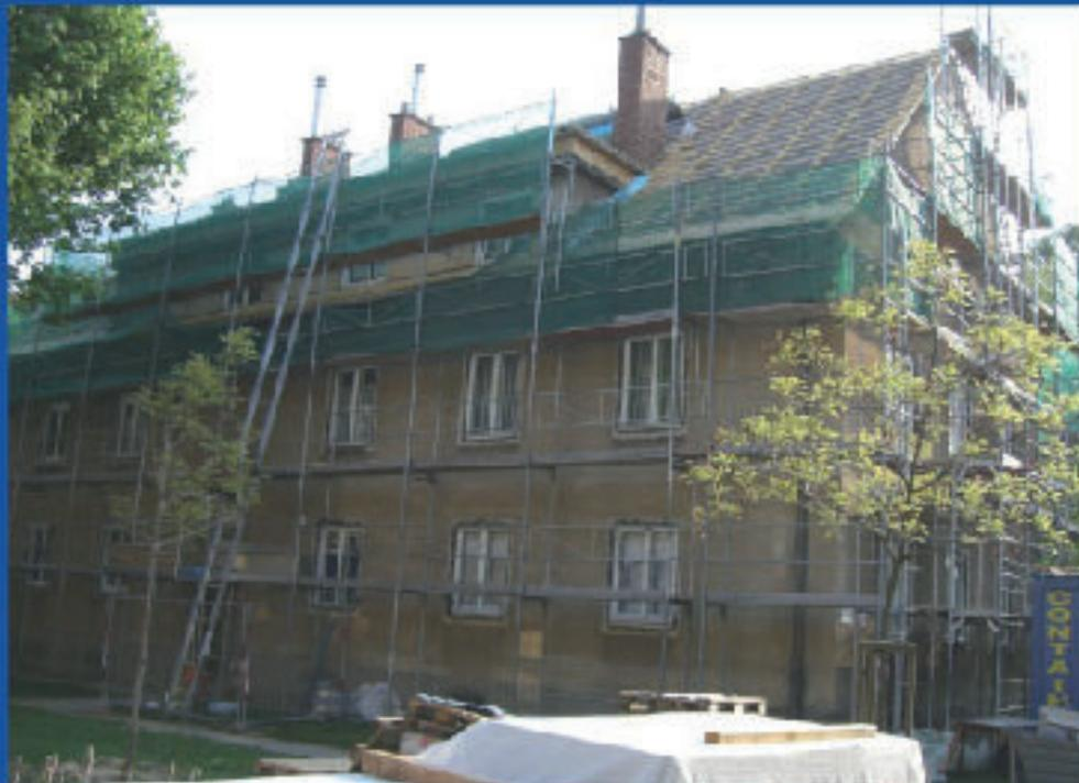
**Beim Gebäude, an dem die Dachschutzblende montiert wurde, können die Baulifte am Gerüst angebracht werden. Die Gerüstarbeiten werden dadurch nicht behindert.**
